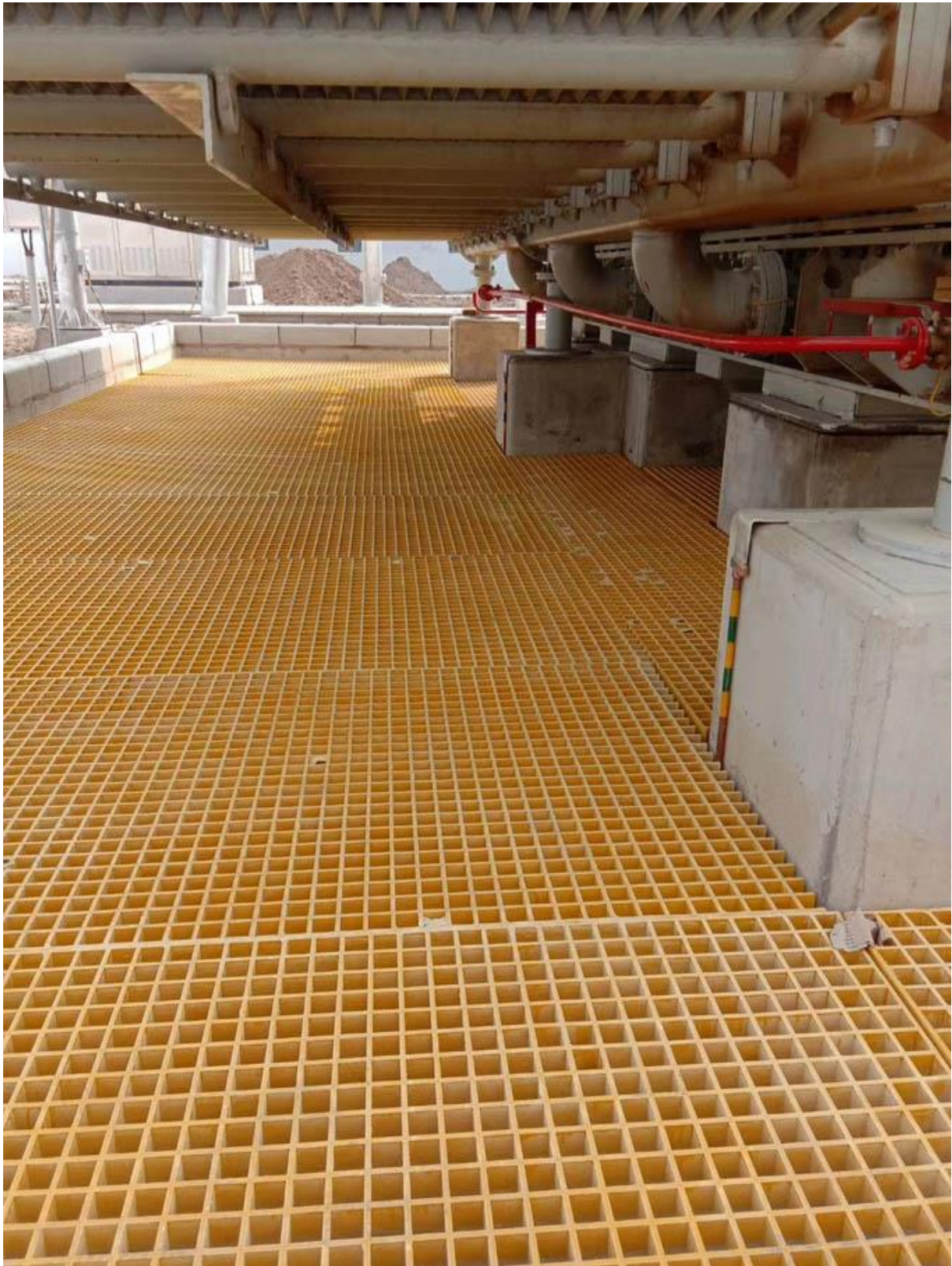
1.污水处理场滤池用拉挤格栅.
